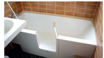
Der nachträgliche Einbau einer Türe in die bestehende Badewanne ermöglicht einen sicheren Ein-/Ausstieg. Einfacher Einbau ohne Schmutz innert 5-7 Stunden.
